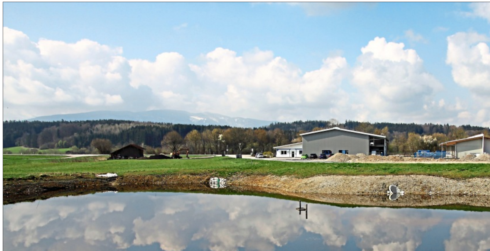
Das Regenwasserbecken im Gewerbegebiet Wasserbrenner: Sorgen bereitet bei Starkregen der Schmutzwasserkanal.
